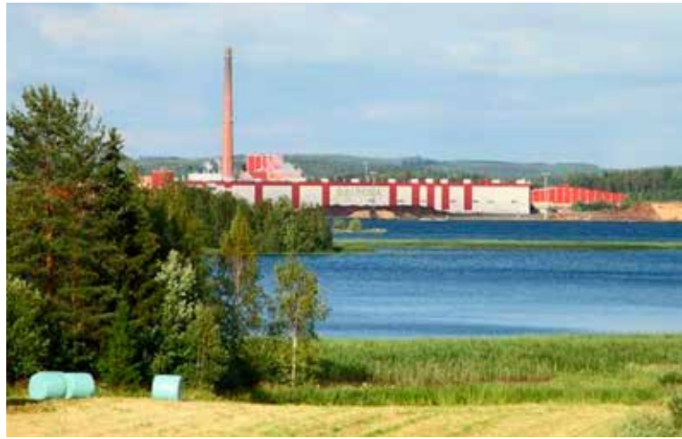
Kaipolan tehdasalueella on valmis, moderni teollisuusinfra.
