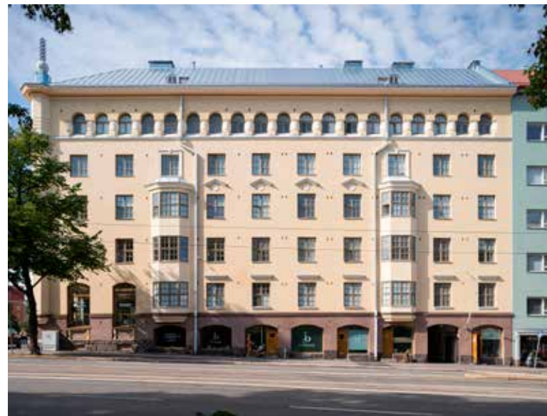
Helsinkiläisen Asunto Oy Euran julkisivuremontti voitti Julkisivuremontti 2023 -palkinnon.
