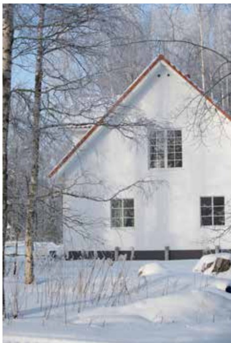
Kivitalossa lämpö säilyy pidempään.
