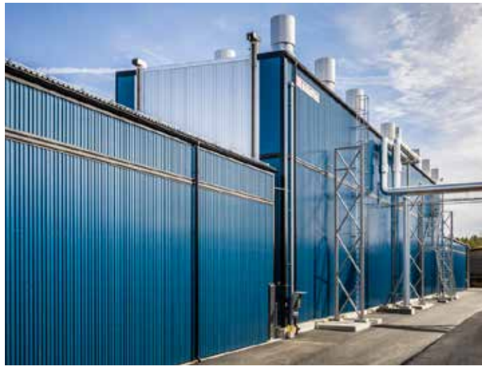
■ TC-kanavakuivaamossa yhdistyvät kamarikuivauksen laatu ja joustavuus kanavakuivauksen tehokkuuteen.
