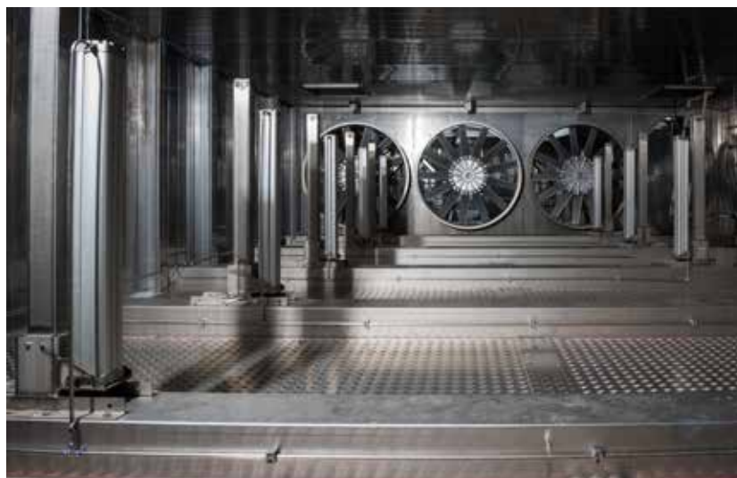
■ Kuivaamon sisällä oleva välitaso.
