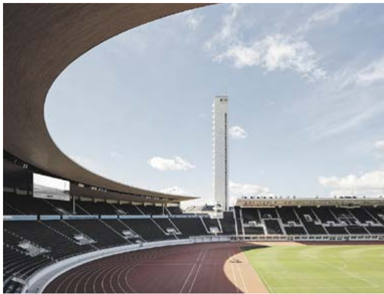
Vuoden 2020 betonirakenne, Olympiastadionin perusparannus ja uudistaminen. Kuvaaja: Tuomas-Uusheimo
