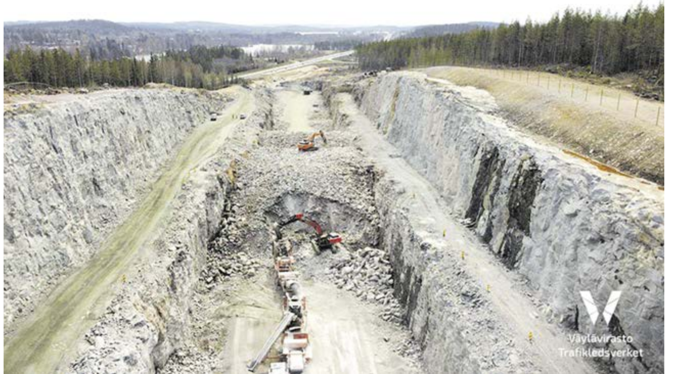
Valtatie 4:n uusi tielinja halkoo Kirrinkalliota noin 800 metrin matkalta. Kallioleikkauksen pohjalla on murskausasema. Kuva on otettu pohjoisesta etelään ja taustalla näkyy Nelostie (Vt4)
