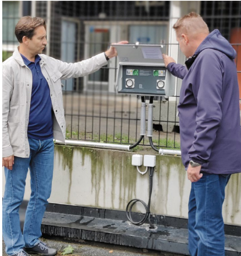
Kari Ojala ja Arto Pollari tarkastelevat As. Oy Jyväskylän Säästökeskuksen piha-alueelle asennettuja hybridikoteloita, joissa on pistokkeet sekä auton lämmitykseen että sähköauton lataamiseen.
