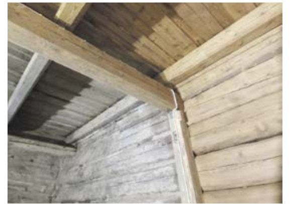
Kalkkimaalin puhallusta hirsiseinästä.
