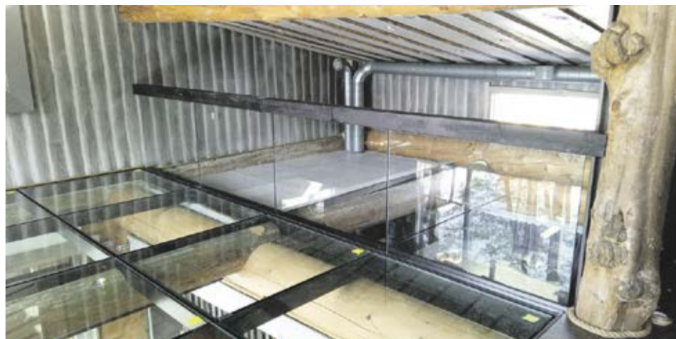
Toimittamamme lasilattia ja tolpaton lasikaide. Lasilattiassa käytetään yleisesti karkaistua ja laminoitua lasia 3*10mm.
