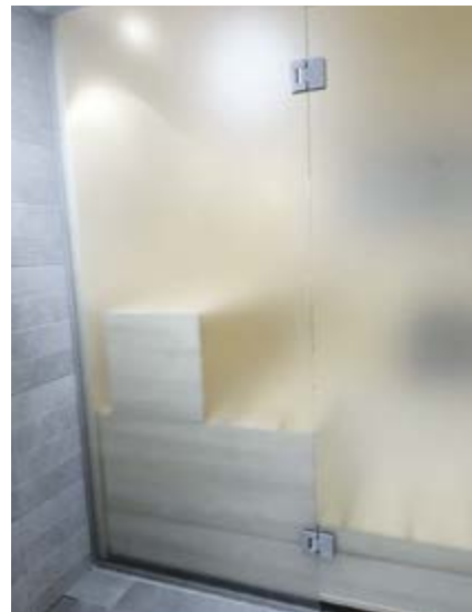
Saunan seinä on toteutettu optiwhite-lasilla, joka on oksidipuhallettu ja nanopinnoitettu. Pinnoite estää saatiinipinnan kastumista ja lasin muuttamista laikukkaaksi kosteuden vaikutuksesta.
