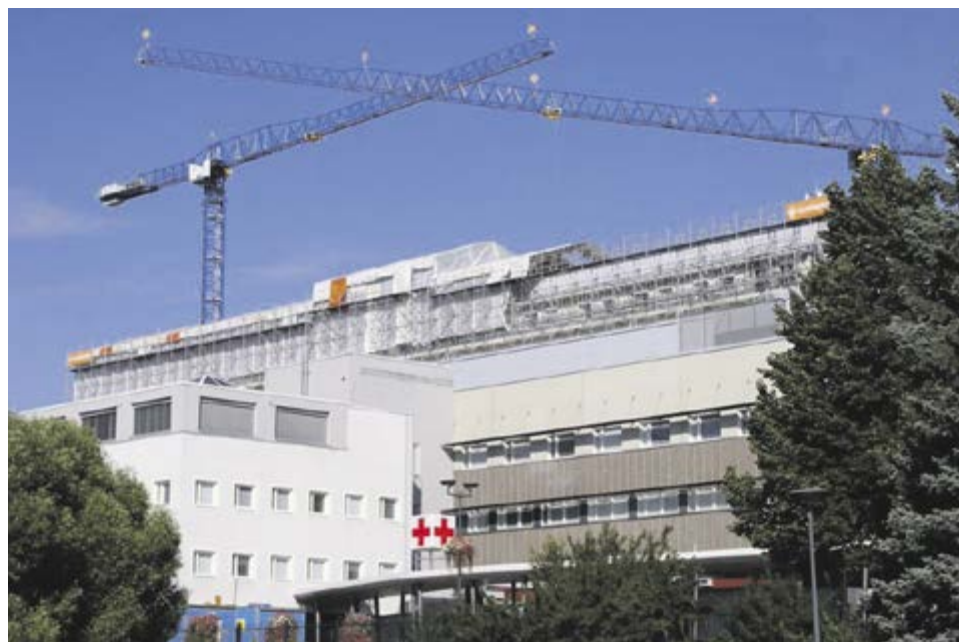
Suuri valtakunnallinen soteuudistus voi jatkaa ellei jopa lisää sairaalatilojen lisä- ja korjausrakentamista Pohjois-Savossakin.
