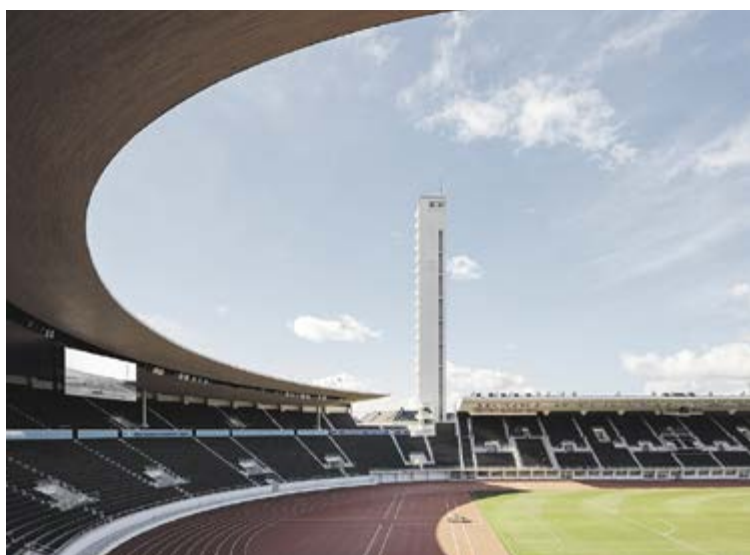
Vuoden 2020 betonirakenne, Olympiastadionin perusparannus ja uudistaminen. Kuvaaja: Tuomas-Uusheimo
