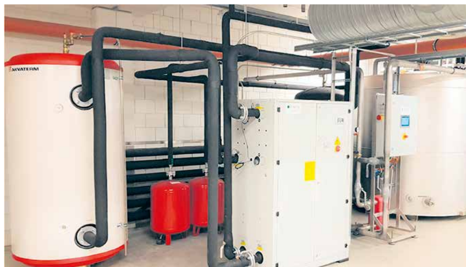
Höyrynjakotukin, lauhdesäiliön ja hönkähöyryn LTO-siirtimen käyttöönotto teollisuuslaitoksessa.
