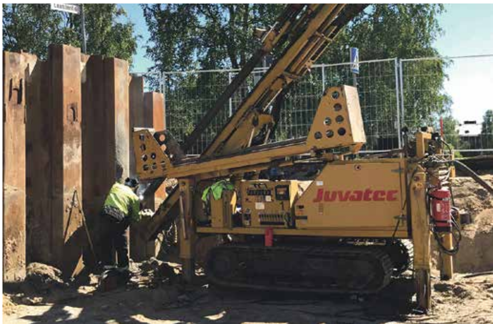
Tukiseinän ankkurointi (rakennusteollisuus)
