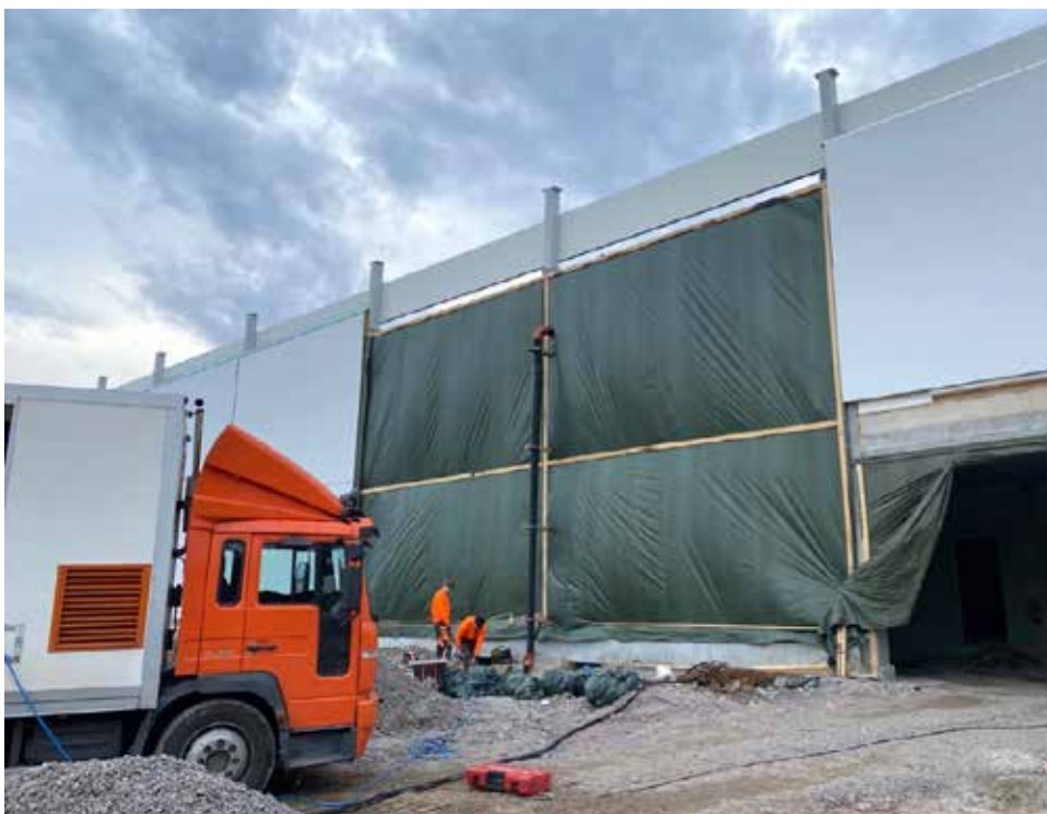
Liikuntakeskuksen perustusten nosto- ja stabilointityötä pääkaupunkiseudulla.
