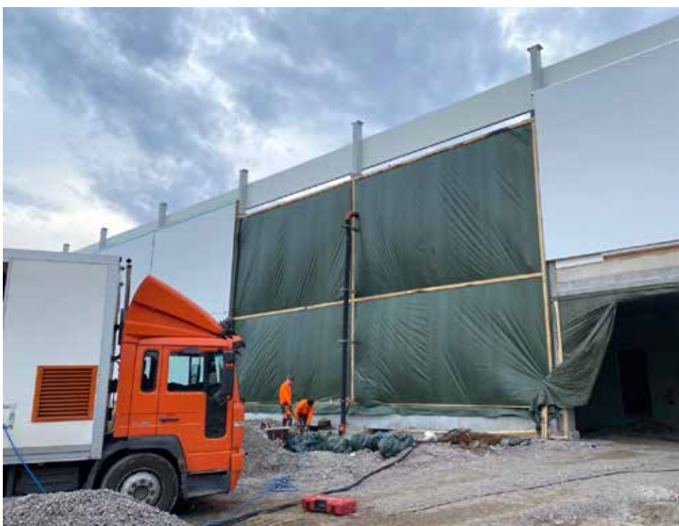
Liikuntakeskuksen perustusten nosto- ja stabilointityötä pääkaupunkiseudulla.
