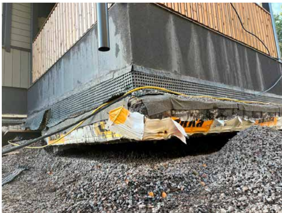
Kesämökin nosto- ja stabilointityö +20cm verran.
