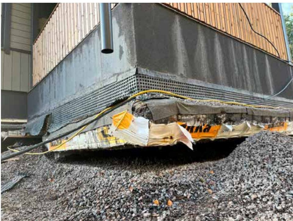
Kesämökin nosto- ja stabilointityö +20cm verran.
