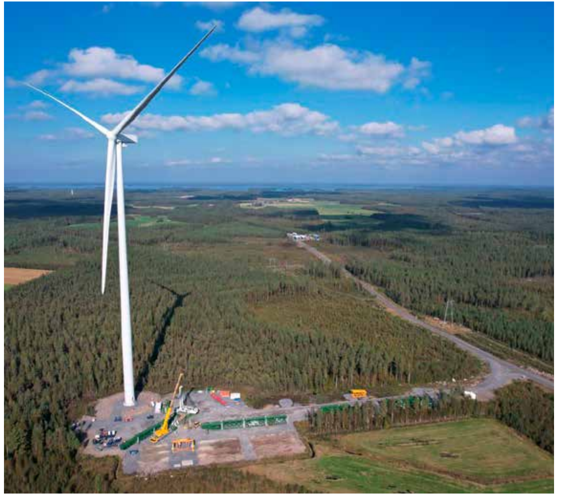
Kuvassa Lestijärven tuulipuiston ensimmäinen täyteen korkeuteensa valmistunut voimala.
