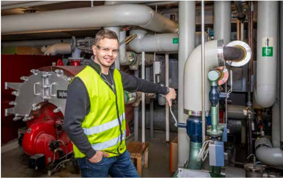
Kuvassa Valmetin kunnossapitopäällikkö Juha Katainen.
