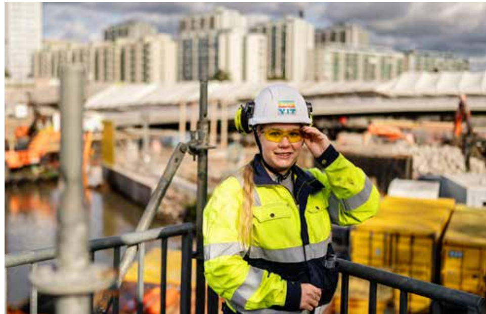
Asuntorakentamisen alhosta huolimatta yli puolet rakennusyrityksistä on kohdannut rekrytointivaikeuksia tänä vuonna. Työnjohtoharjoittelija Netta Korhonen Kruunusiltojen työmaalla syksyllä 2024. Kuva: Aki Rask
