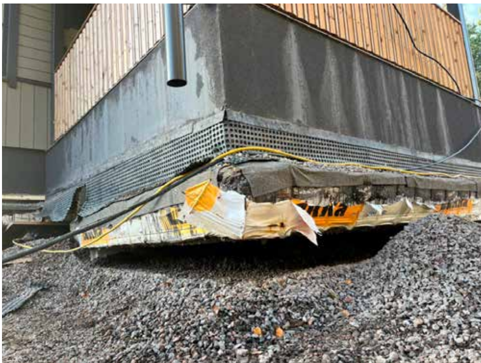
Kesämökin nosto- ja stabilointityö +20cm verran.
