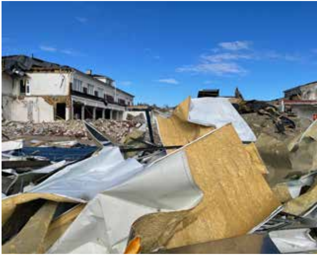
Jopa 1990-luvun rakennuksia puretaan. Kuvan liikera-kennus väistyi uuden vastaavan tieltä.
