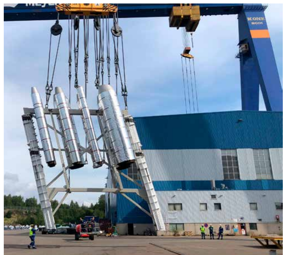
Kuvassa nostetaan Tejaran valmistamaa laivan teleskooppipiippua
