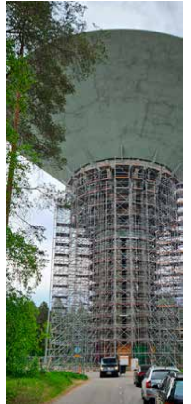
Puolivälänkankaan vesitornia saneerattiin v. 2023.
