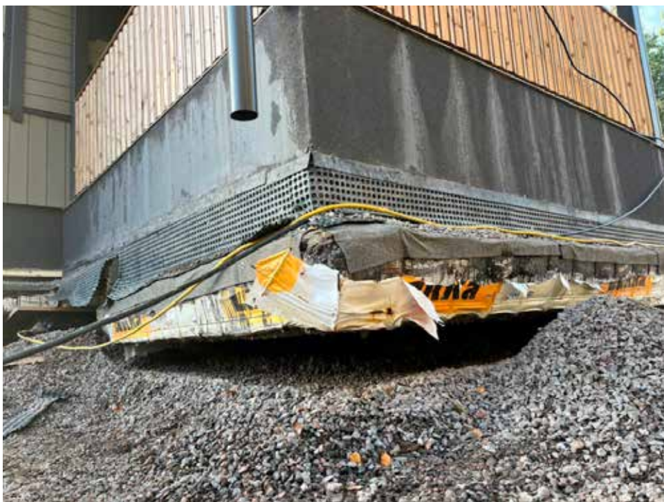
Kesämökin nosto- ja stabilointityö +20cm verran.
