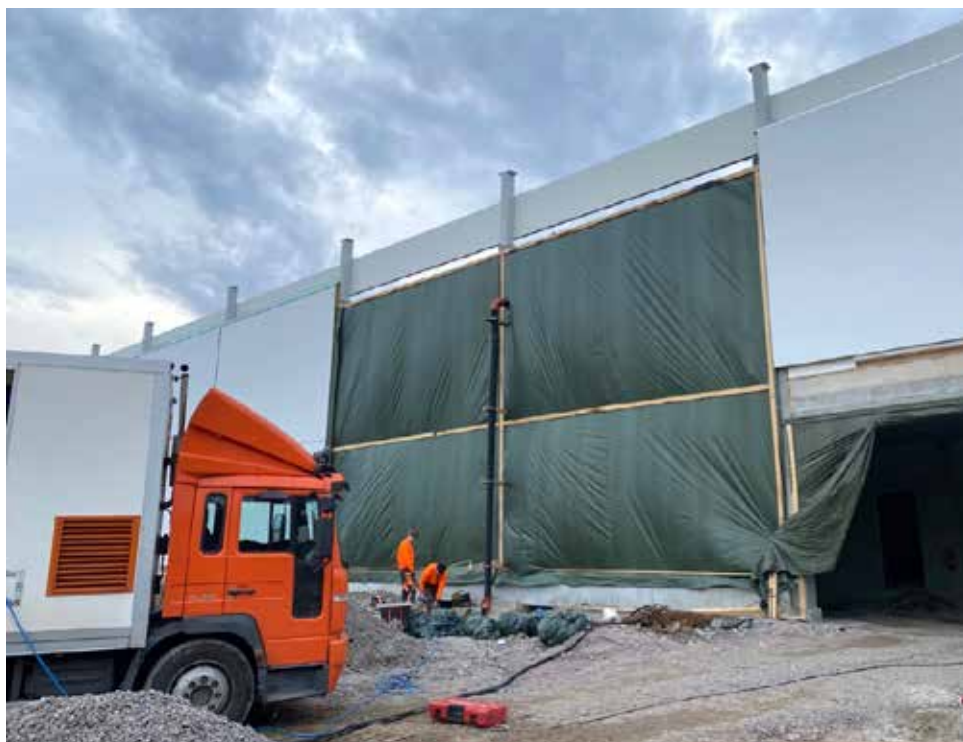
Liikuntakeskuksen perustusten nosto- ja stabilointityötä pääkaupunkiseudulla.
