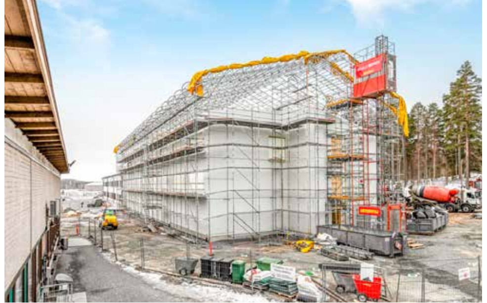
Karjalan lennoston rakennustyömaa Rissalassa.
