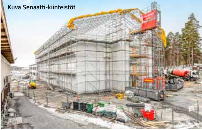
Kuva Senaatti-kiinteistöt Karjalainen lennoston rakennustyömaa Rissalassa.
