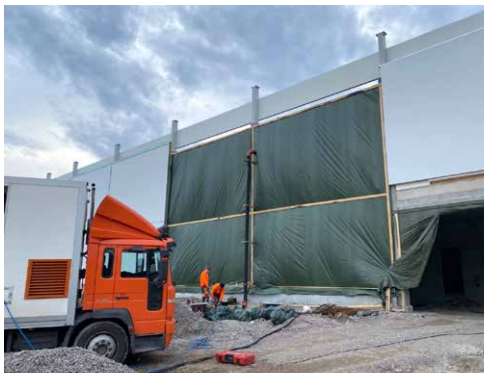
Liikuntakeskuksen perustusten nosto- ja stabilointityötä pääkaupunkiseudulla.
