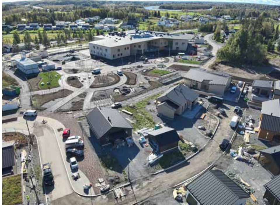
Saikkaan rakennetaan 19 omakotitaloa, 2 paritaloa, 2 rivitaloa, 1 kaupunkipientalo, 1 kerrostalo sekä Saikantalo, jossa tulee toimimaan alueen päiväkotia ja alakoulu. Kuvapalvelu Salopino
