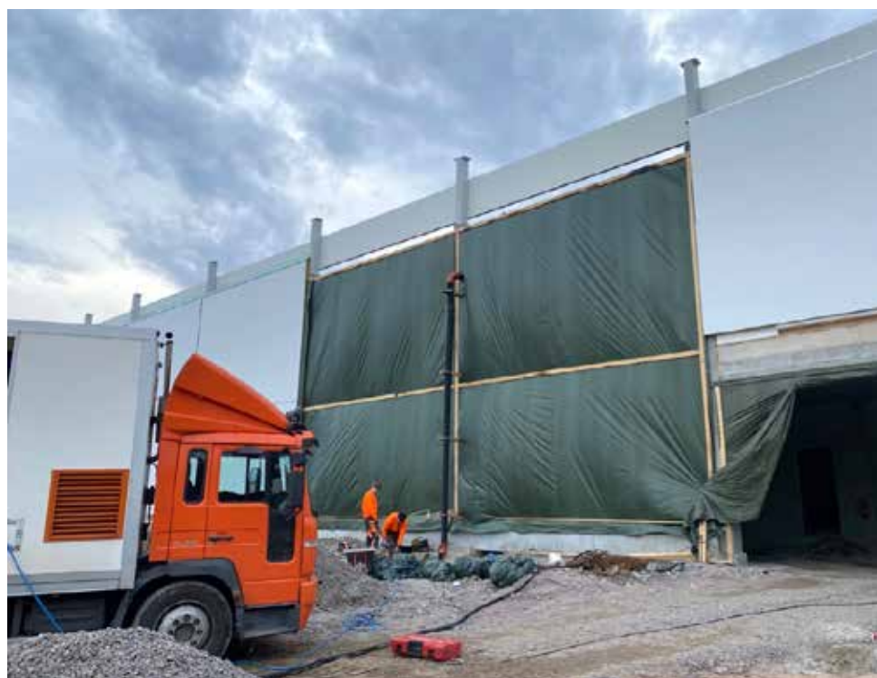
Liikuntakeskuksen perustusten nosto- ja stabilointityötä pääkaupunkiseudulla.
