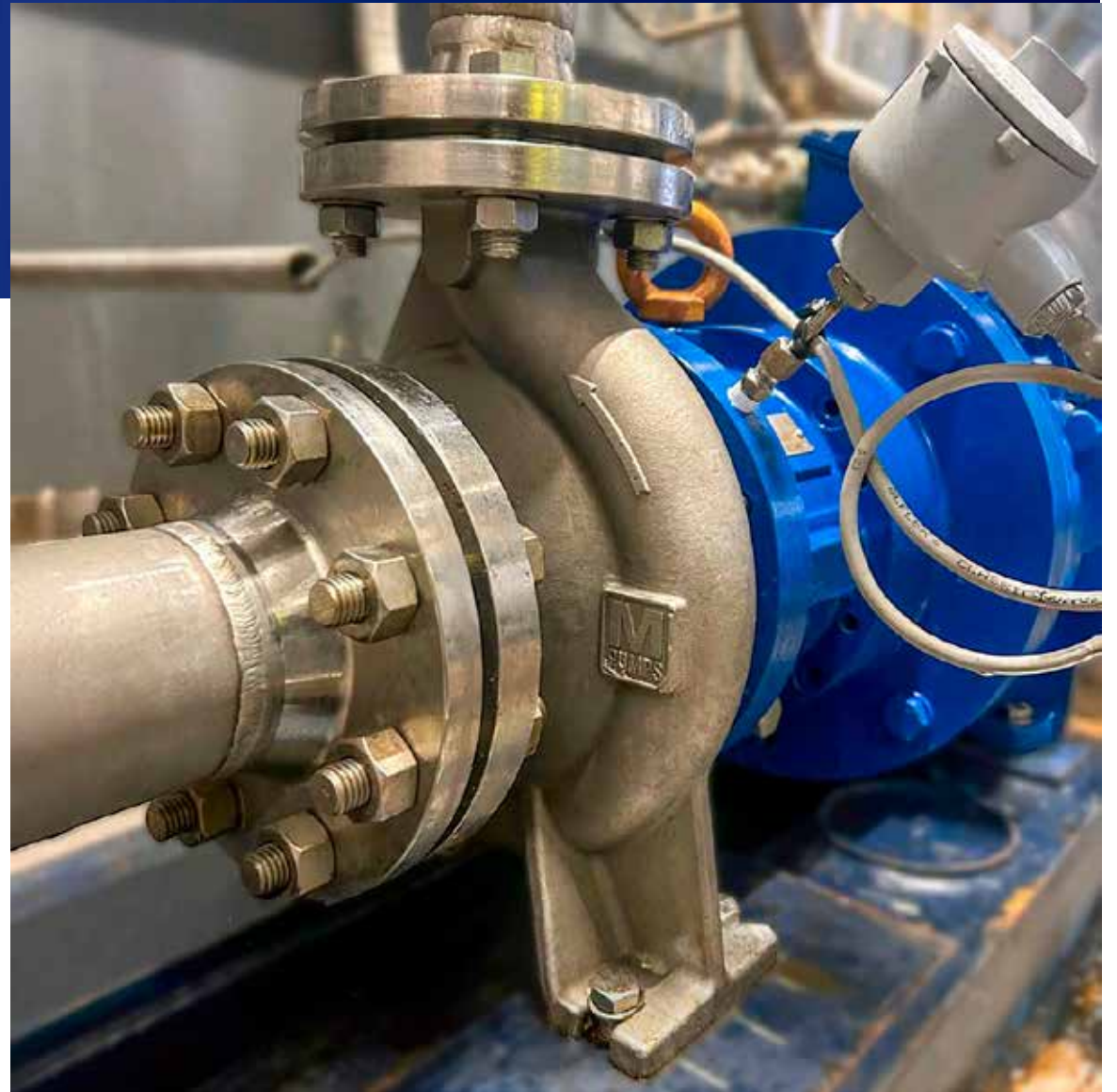
M-Pumpsin magneettivetoiset pumput takaavat turvallisen pumppauksen vaarallisille aineille.
