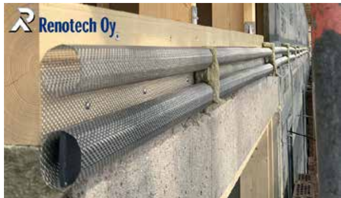
FB-onteloventtiili räystäsrakenteeseen asennettuna.
