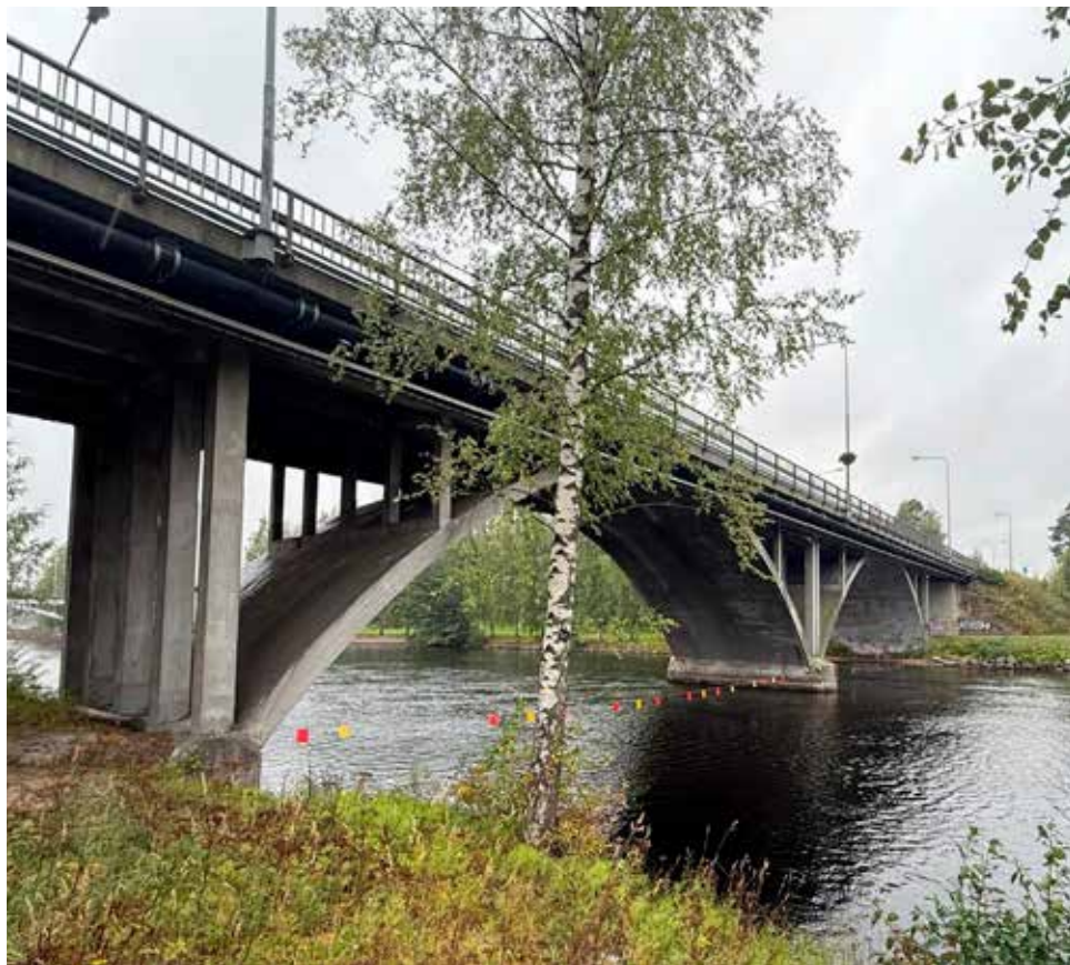
Kreate rakentaa reilun 8,5 miljoonan euron urakassa uuden sillan Äänekoskelle vanhan 50-luvulla rakennetun sillan tilalle. Kuva Kreate.
