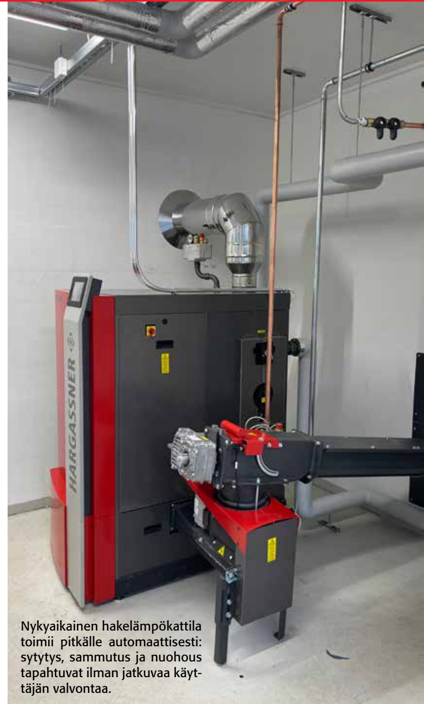
Kompakti rakenne mahdollistaa hakelämmityksen myös yllättävän pieniin tiloihin – järjestelmä voidaan sovittaa erilaisiin saneeraus- ja uudiskohteisiin.
