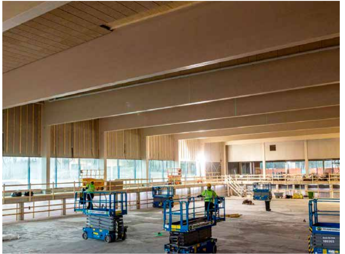
Elmon uimahallissa sisäkattojen työt pitää tehdä ennen kuin allasasennukset alkavat. Kuvassa näkyy 50 metrin pääaltan tila.
