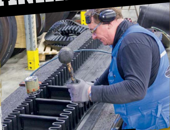
Hihnatyöt ja asennukset
