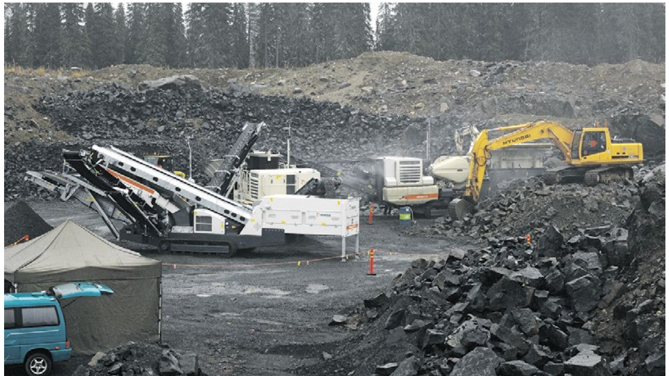
Kaivosalan koulutuksen rinnalla OSAOn Taivalkosken yksikössä myös maarakennuskoneen kuljettajat saavat vahvan kokemuksen murskaus- ja kaivannaisalan toiminnasta.
