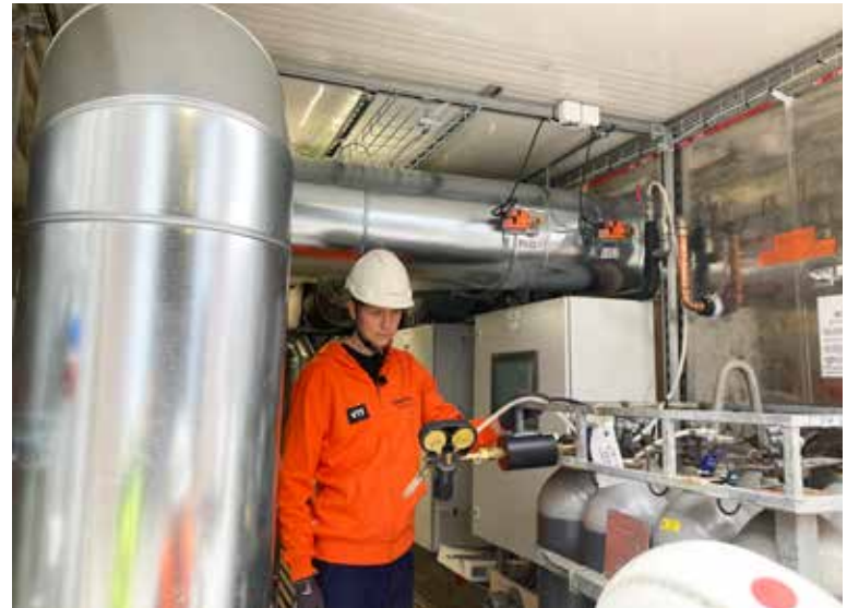
VTT:n erikoistutkija Tapio Vehmas Carbonaide-yksikössä Rakennusbetoni- ja Elementti Oy:llä syksyllä 2022. Kuvalähde: VTT.
