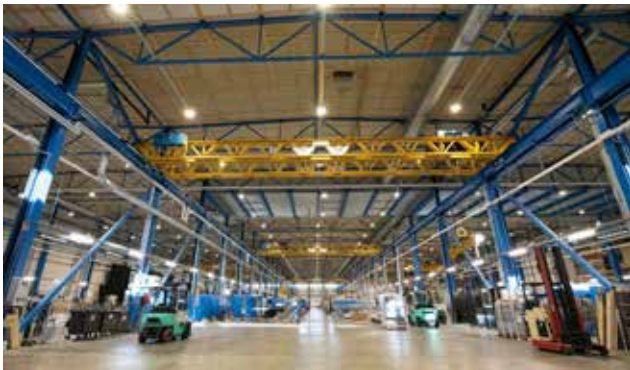
Trutec on toimittanut Prima Powerin hallin teräsrakenteet tuoteosakauppana.
