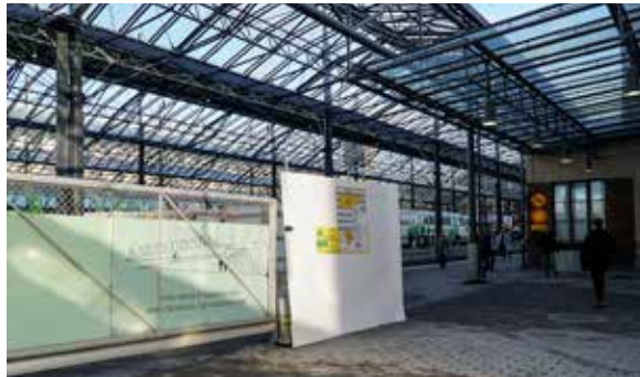
Kaisantunnelin työmaan aita Helsingin päärautatieasemalla.
