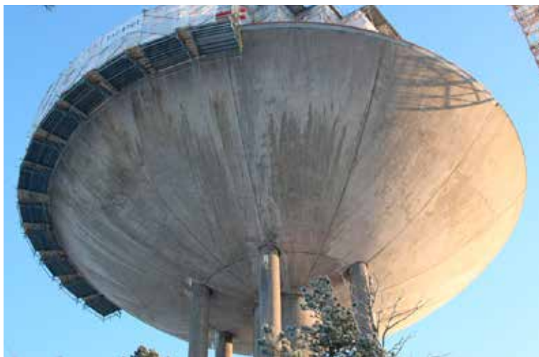
Rakennesuunnittelussa poikkeuksellisen vaativia betonirakenteita ovat esimerkiksi vesitornit. Kuvassa Haukilahden vesitorni Espoossa. Kuva: Esko Sistonen.
