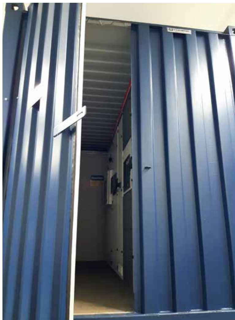
● Muuntamokontti valmiina toimitukseen
