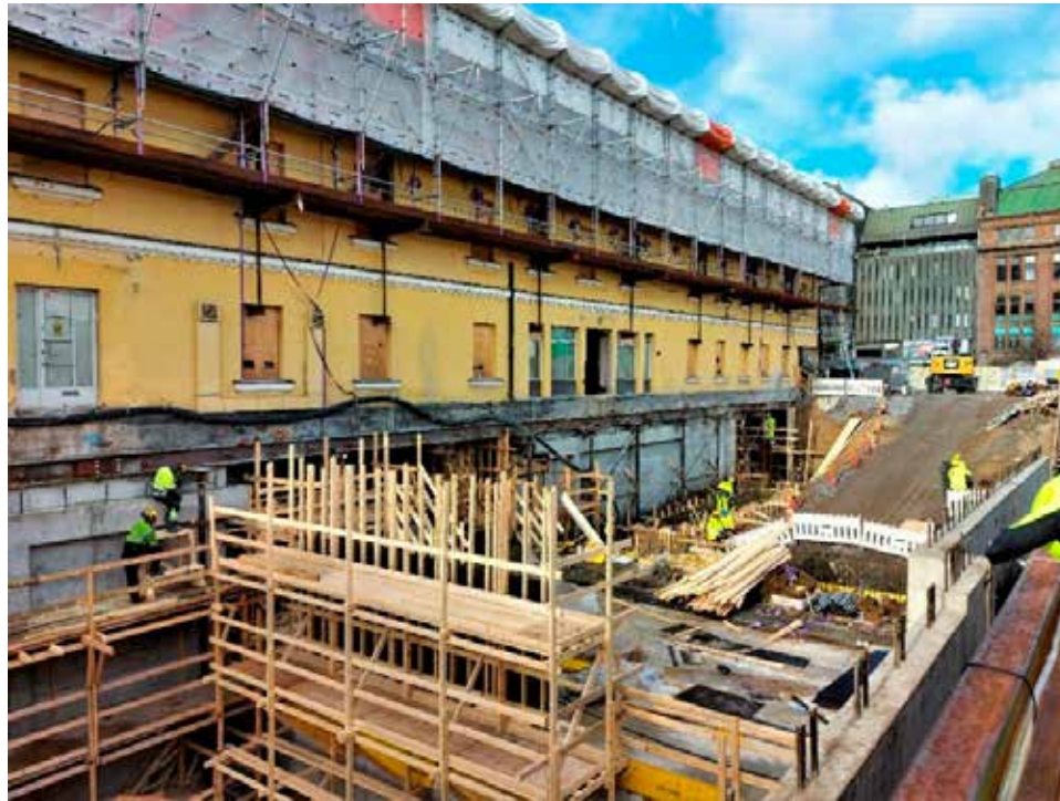
SRV:n Kulttuurikasarmin työmaa Helsingin Lasipalatsin aukiolla.
