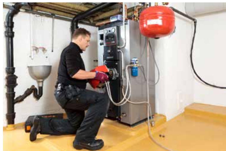
Polttinhuolto mittauksineen on osaavan ammattilaisen tehtävä, mutta kattilan puhtaanapito sopii asukkaalle itselleenkin.
