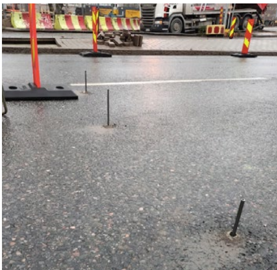
Injektointimenetelmällä voidaan maaperää vakauttaa ja nostaa esimerkiksi vajonneilla tieosuuksilla.
